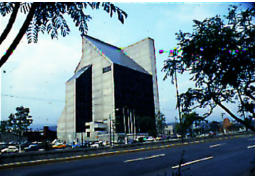
EDIFICIO CORPORATIVO DE TRANSPORTACIÓN MARÍTIMA MEXICANA S.A., PERIFÉRICO SUR EN MÉXICO, D.F.
